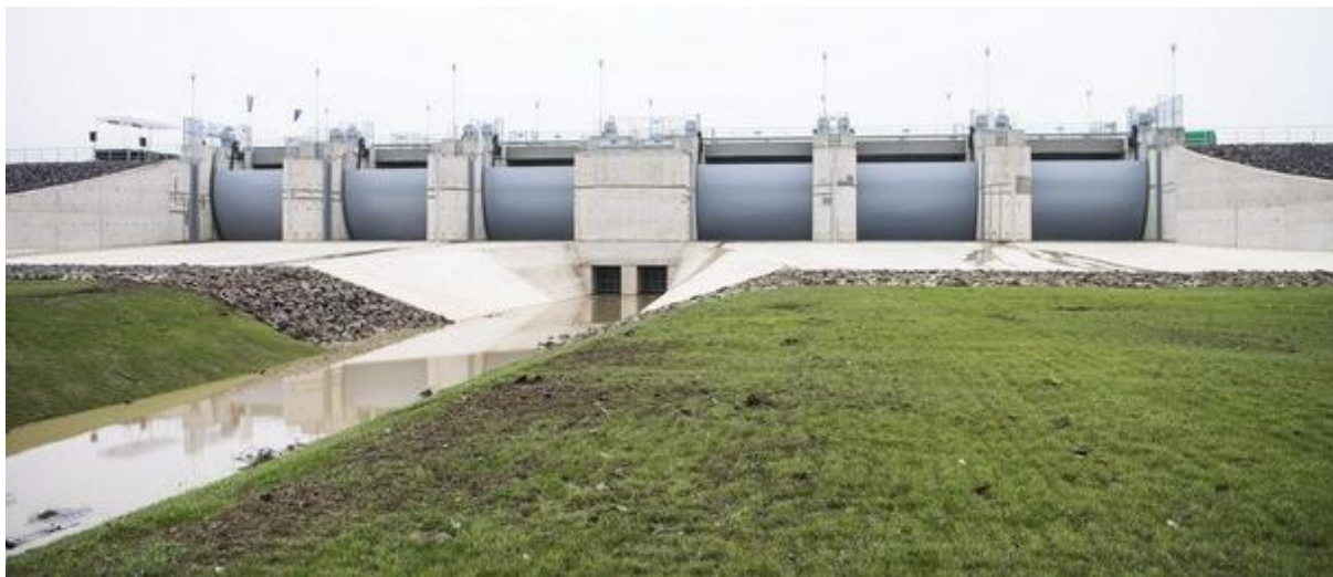
4.23. ábra: A Beregi árapasztó tározó 6 db szegmenstáblából álló beeresztő műtárgya Tarpa és Tivadar között Forrás: MTI/Balázs Attila
